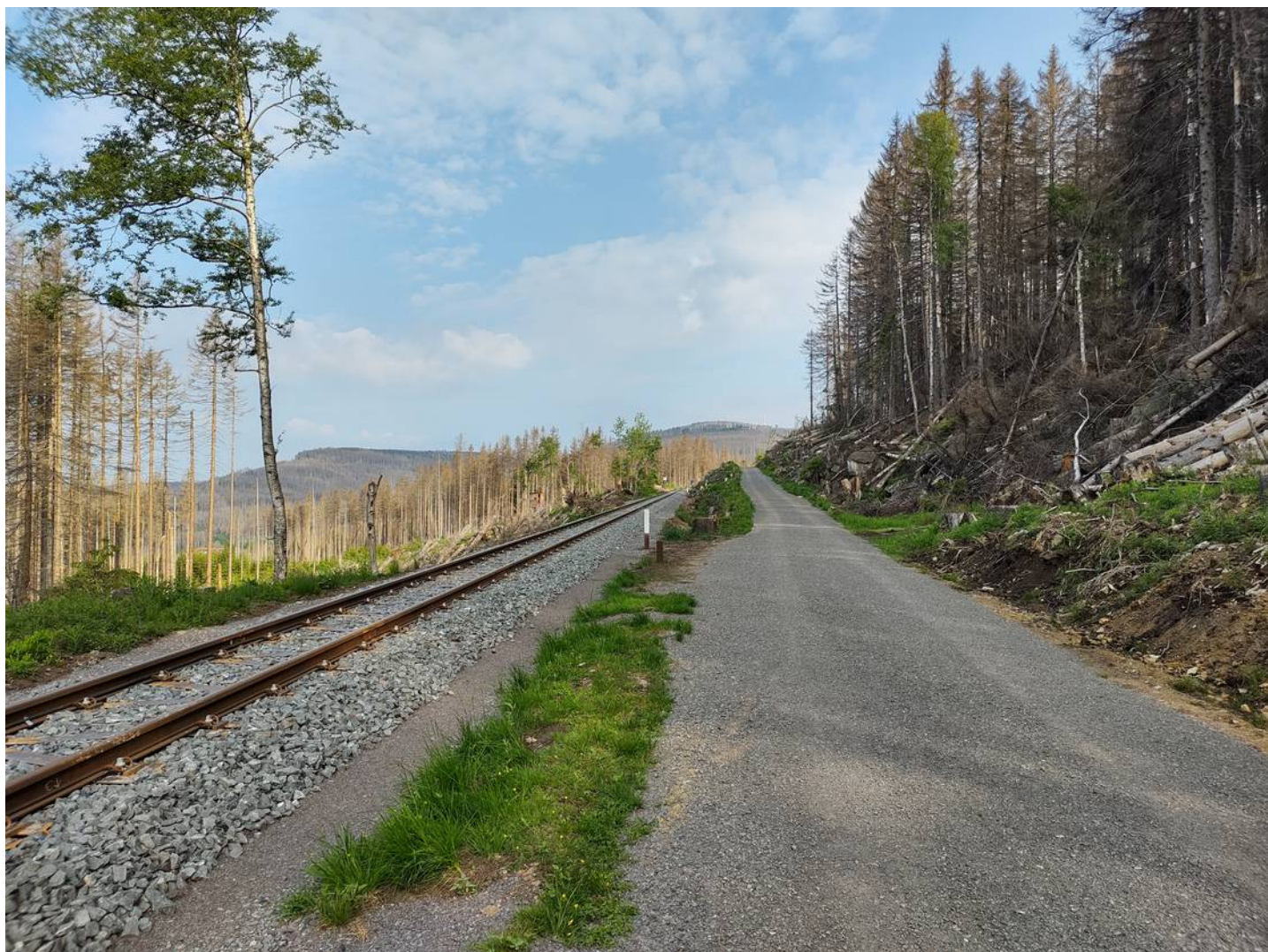
Erneuerte Gleise der Brockenbahn oberhalb von Schierke
