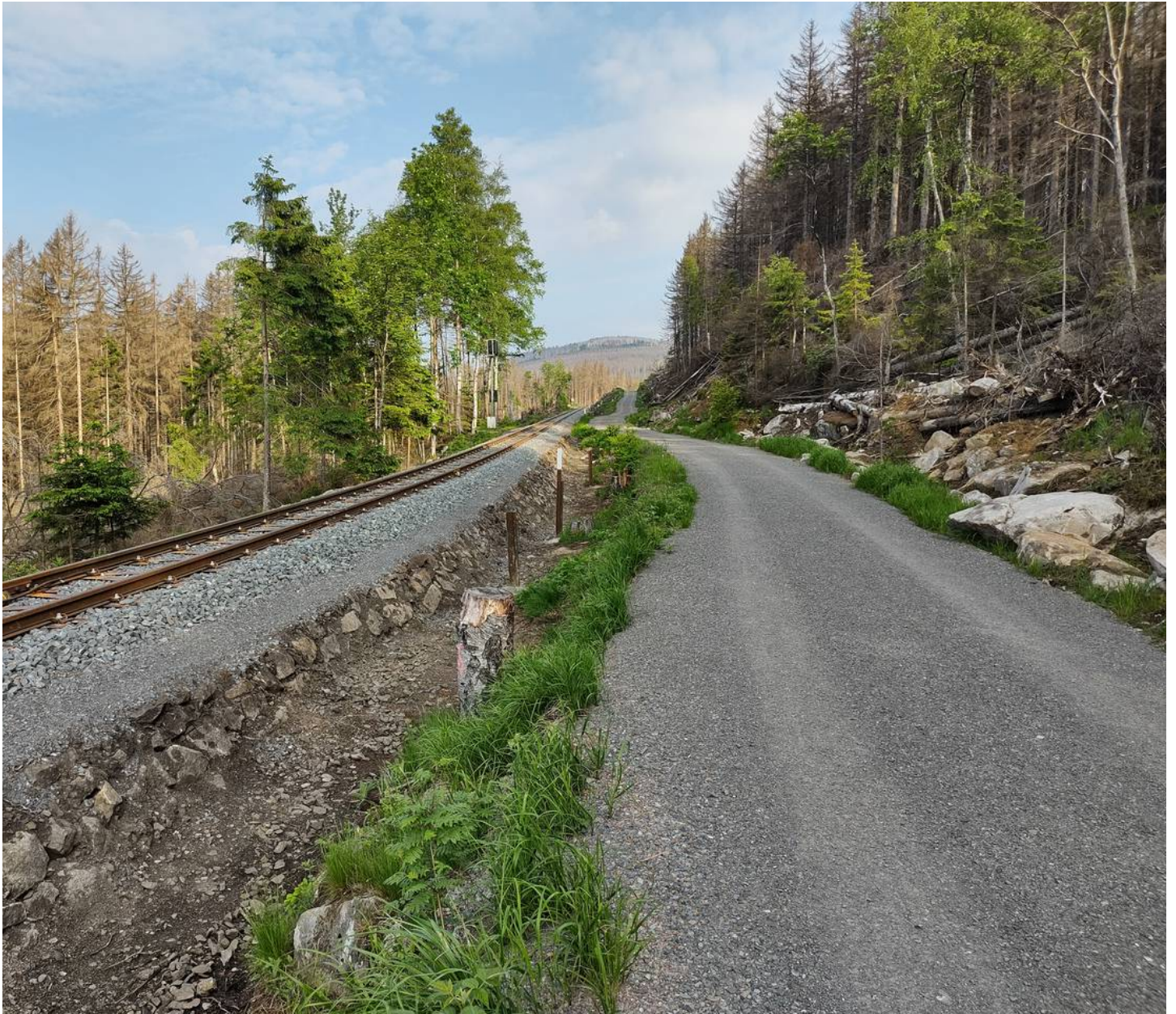
erneuerte Gleise für den Brockenbahn und erneuerter Bahnparallellweg am 9.6.2021
